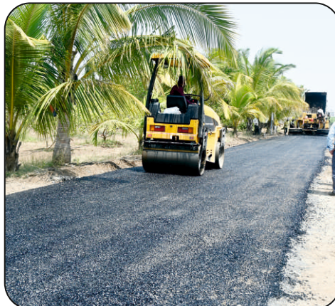
फार्म में WBM सड़क का निर्माण
